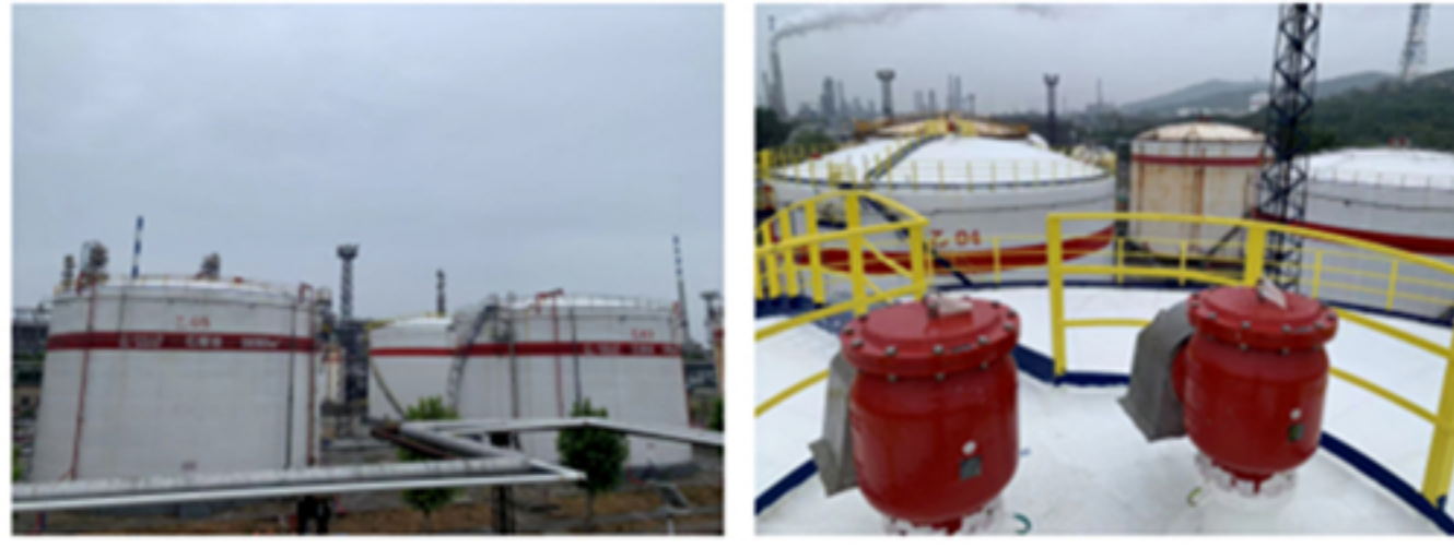
为轻/重质油储罐加装“红帽子”（新型VOCs呼吸阀）
